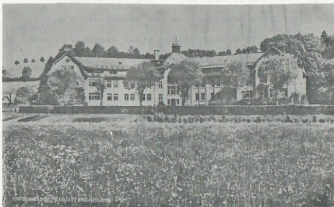
Kreis Krankenhaus Immenstadt (von 1. Jan. 1909 - 30. Aug. 1968)
